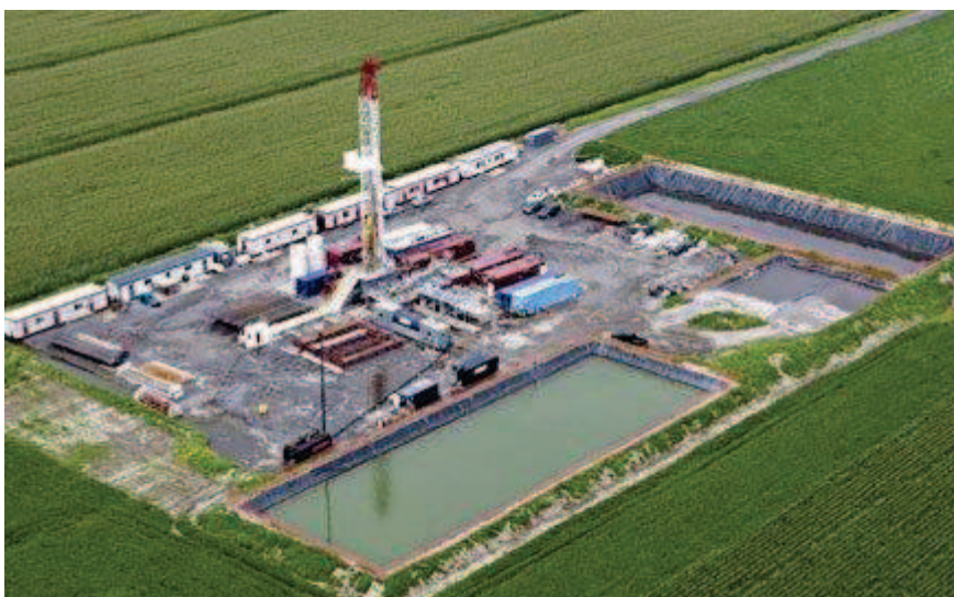
Figure 3 : Vue aérienne du forage de gaz de schiste de Saint-Barnabé Sud au Québec (source : François Roy, La Presse)
