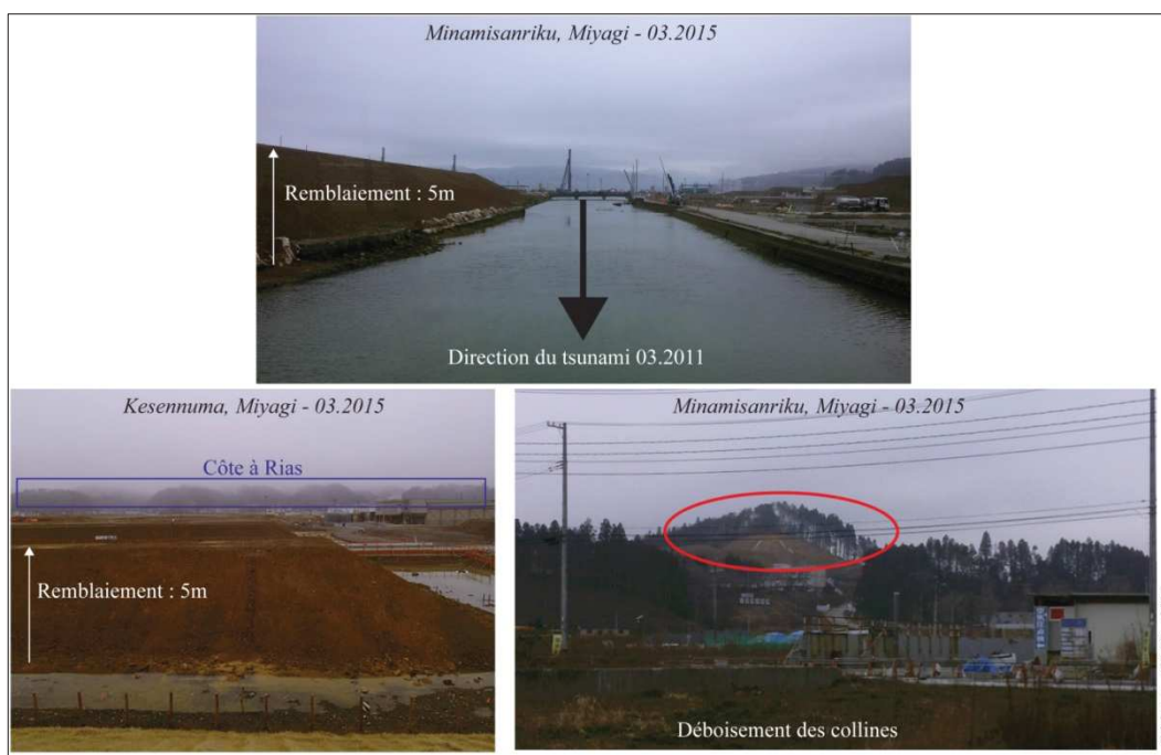
Figure 66 : Remblaiement et déboisement pour la reconstruction dans la province de Miyagi (Japon) suite au tsunami de 2011
