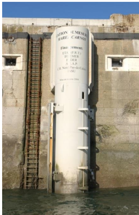
Figure 1.11. Station de mesure MAREL-Carnot.
