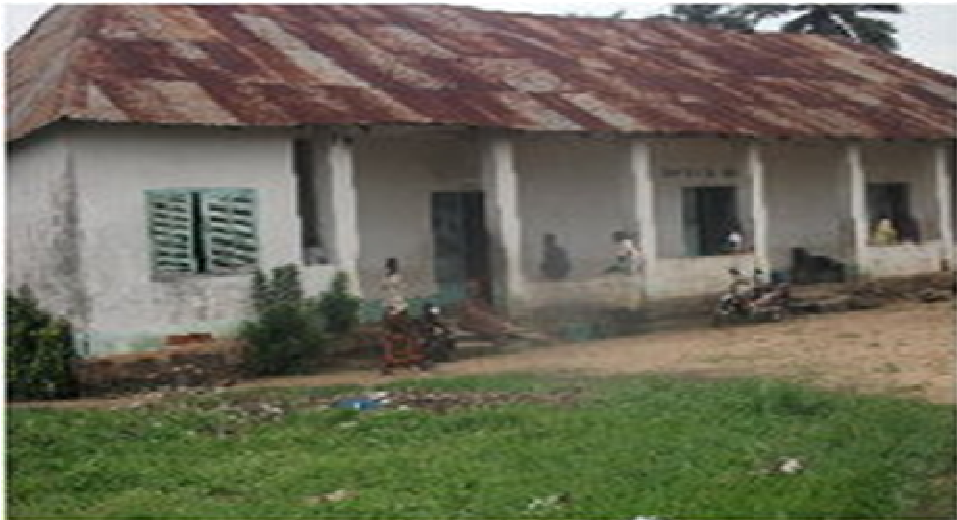
Figure 6 : Hôpital de base de Gamboma (Bâtiment de médecine) (source : www. congo-site.com )
