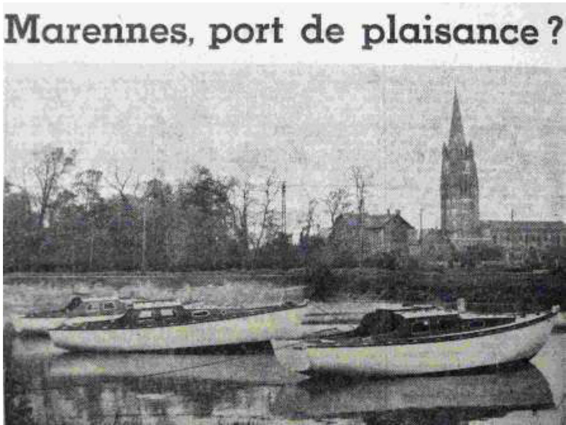
FIGURE 5.2 – Trois yachts Chassiron au mouillage dans le bassin de Marennes 689
