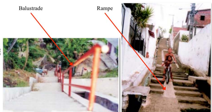
Photos 3-22 et 23 : Escaliers d'accès aux morros avec balustrade et rampe
