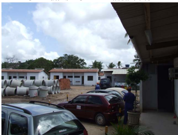
Photo 2-27 : Installations de l'EL et du CDL dans l'UE-17 Passarinho
