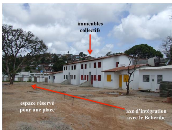
Photo 4-5 : La construction des immeubles collectifs dans Passarinho
