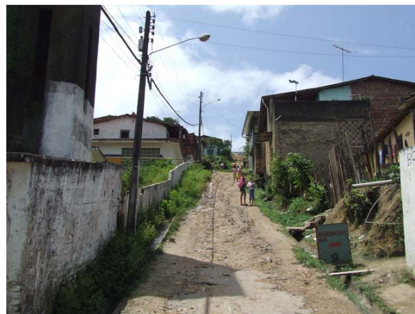
Photo 2-6 : Typologie constructive trouvée sur les morros de l'UE-17
