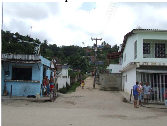
Photo 2-5 : Typologie constructive trouvée dans la plaine de l'UE-17
