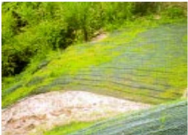
Géotextiles associés aux herbes
