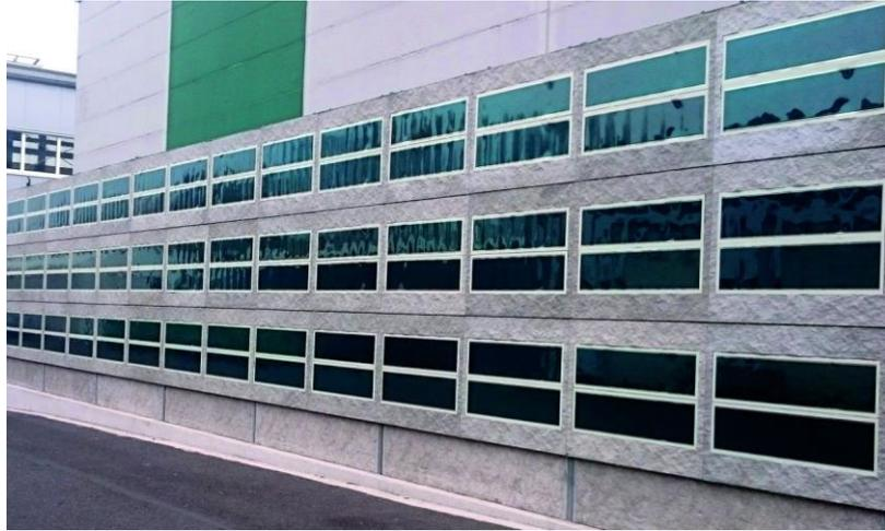
**Figure IV.5. Premier mur solaire à Herne (Allemagne) réalisé avec des panneaux OPV par les entreprises Heliatek et Reckli**
