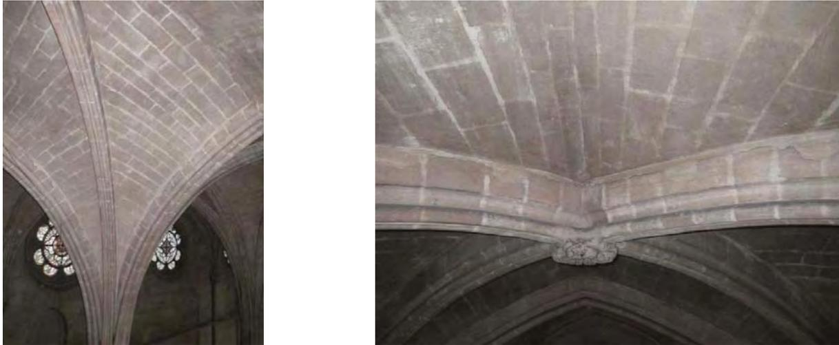
Figure II.4-24: Maçonnerie des voûtes à croisée d'ogives
