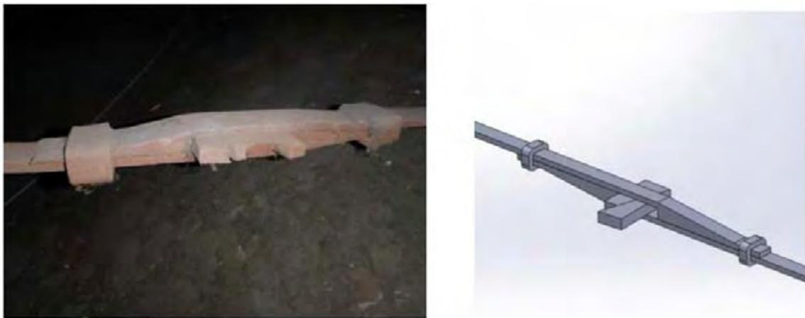
*Figure II.1-14 : Système de mise en tension de tirants, assemblage par clavette*
