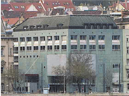
Vue de l'édifice depuis le Danube, au centre le hall d'entrée, dont on distingue la très grande hauteur de plafond ? La cage d'escalier est un espace très ouvert. Elle donne sur le dit passage au second étage
