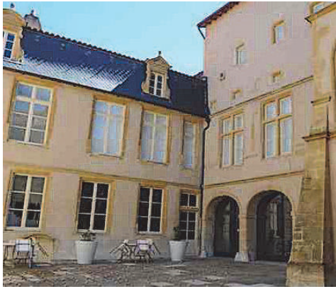
Vue depuis la cour intérieure d'entrée. La salle étudiée se situe entre le premier pot de fleur à gauche et le second à droite et s'étend jusqu'à l'angle du bâtiment (gouttière)
