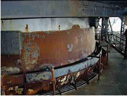
Vue sur le cylindre du Haut Fourneau, ici le côté frontal à la source (la photo a été prise plus tard, d'où le manque d'écoulement d'eau)
