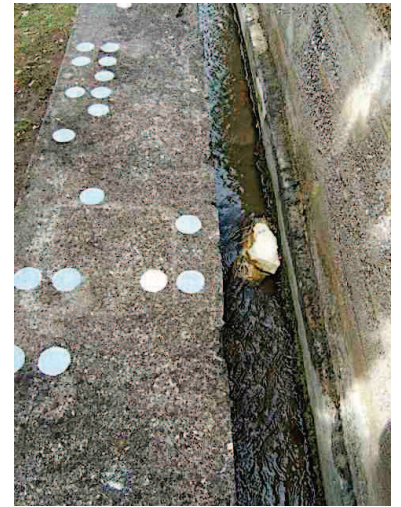
Déviaton par pierre
