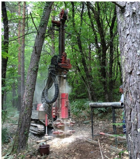
Figure III-9 : Photographie illustrant la mise en place par carottage à l'air comprimée du forage FC4.
