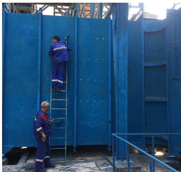
FIGURE 4.2 – Gaine rectangulaire sur laquelle ont été effectuées les mesures. Les points blancs symbolisent les points de mesure de vibrations.
