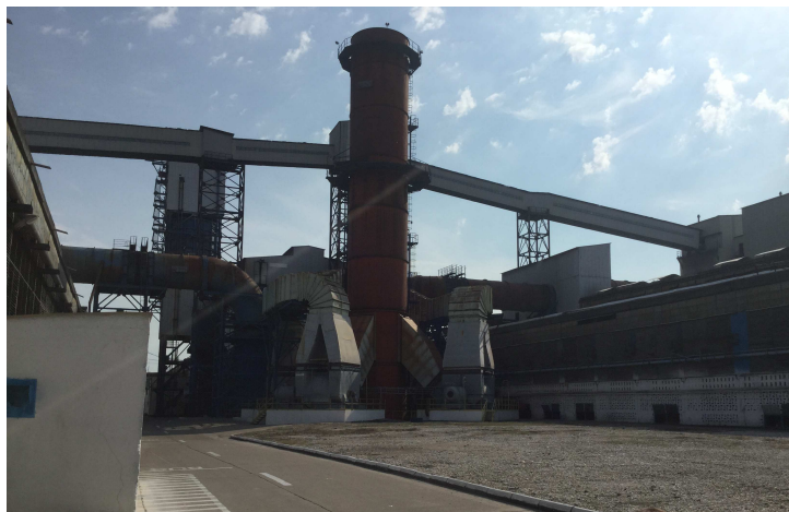
FIGURE 4.1 – Photo d'ensemble du site industriel d'ALRO (Roumanie).
