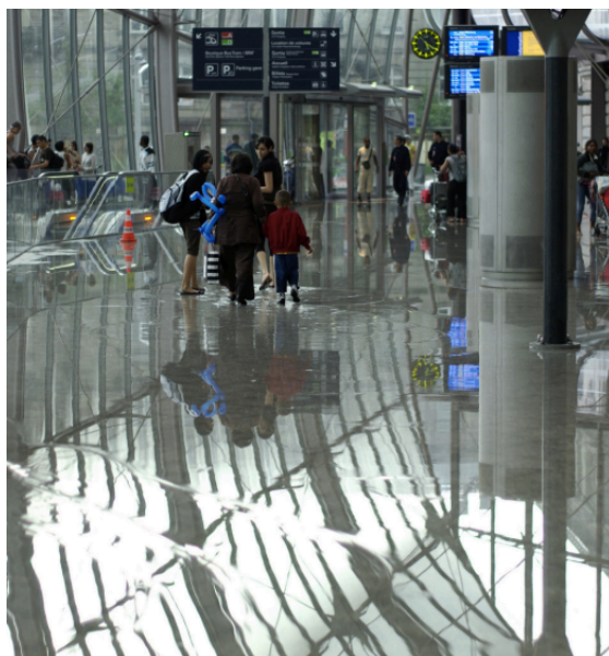
Fig. 36 : La gare de Strasbourg les pieds dans l'eau (2008). Signe d'une vulnérabilité des infrastructures
