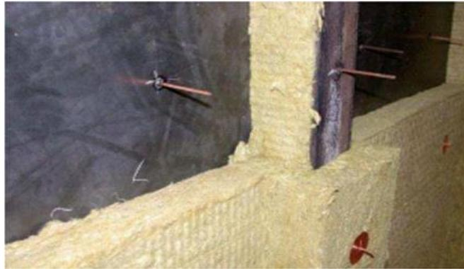
Figure I-1: Isolation incendie sur panneaux métalliques
