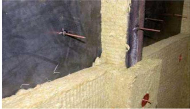
Figure V-4 : Système de tenue de la protection incendie
