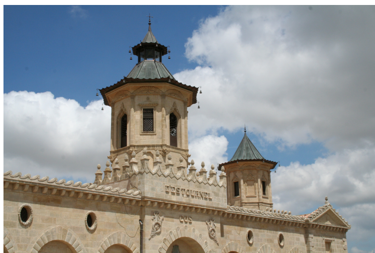
Figure 37 - Détail de l'ancien chai Cos d'Estournel
