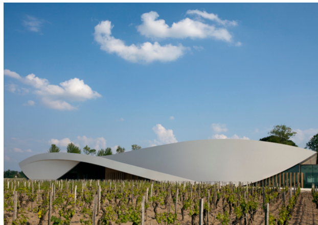
Figure 38 - Détail de l'ancien chai Cos d'Estournel
