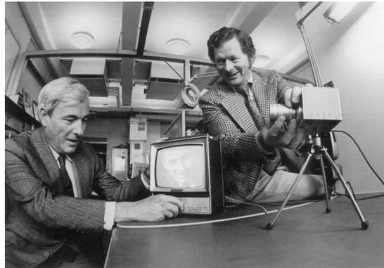
**FIGURE 2.2** – Essai du premier capteur d’images électronique CCD par George E. Smith et Willard Boyle au laboratoire Bell
