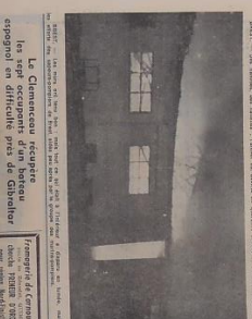
Le feu a éclaté dans le bâtiment d'électro-acoustique de l'usine Cabasse à Brest.
