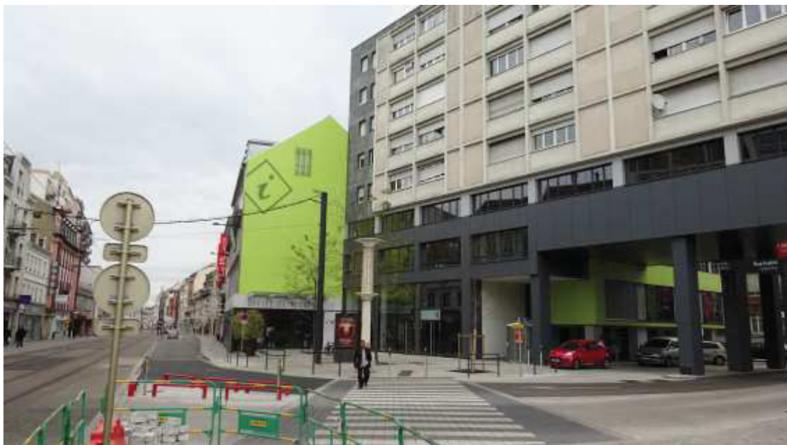
Figure 20 : Façade de l'office de tourisme de Mulhouse et sa région, vue de l'avenue R. Schuman.
