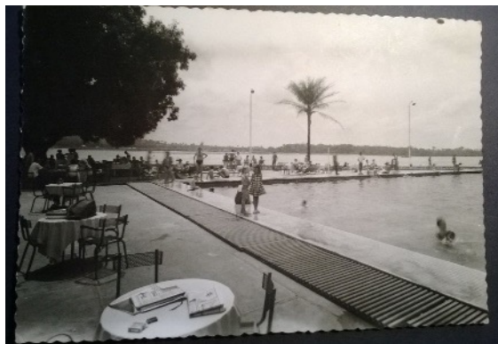
Vue de la piscine et du fleuve, Bangui, République Centrafricaine
