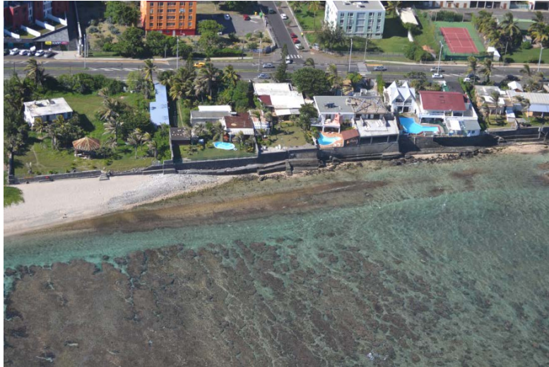
Figure 3-24: Disparition de la plage au-devant de murs d'habitations à Saint-Pierre (05/03/2013 crédit photo : A. Lemahieu )
