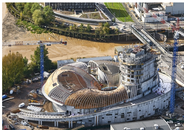
(b) Bâtiment en cours de construction
