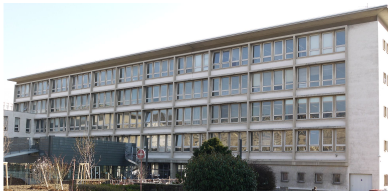
(b) Bâtiment de l'INSA
