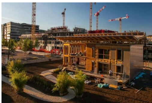
Terra Nostra, démonstrateur d'habitat Terre & Bois Master Cultures constructives ENSAG
