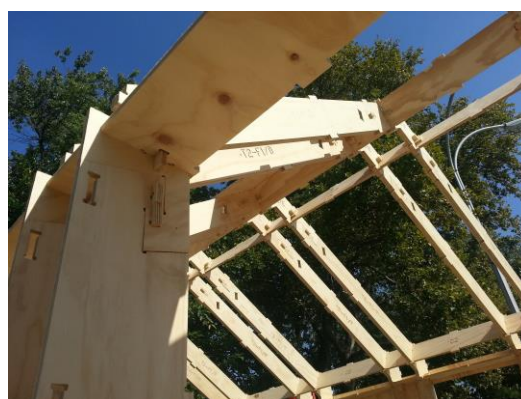
Fig. 15 Double châssis formant portique
