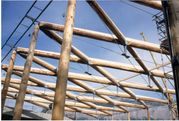
Fig. 1 Charpente du gymnase de Meylan
