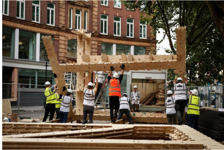
Fig. 21 Montage des portiques
