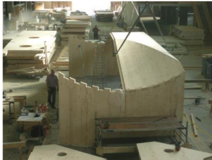
Fig. 22 Fabrication du pavillon par l'entreprise Merck
