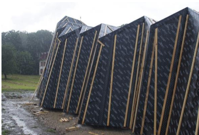
Fig. 20 Enveloppe d'étanchéité sous bardage
