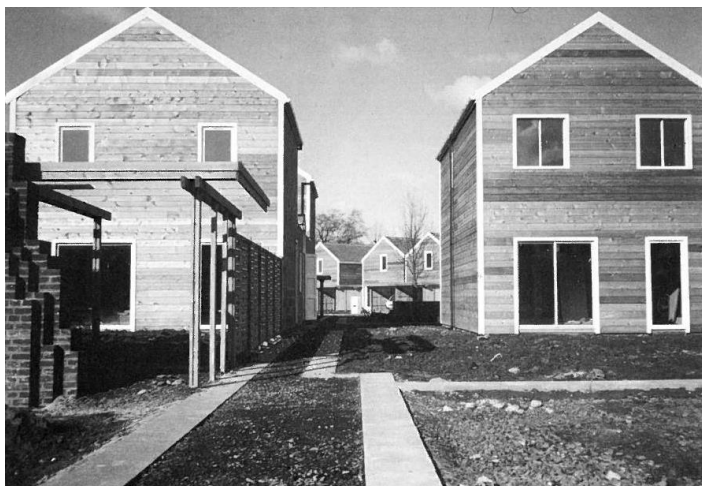
Fig. 37 Pignons en bardage de Red Cedar
