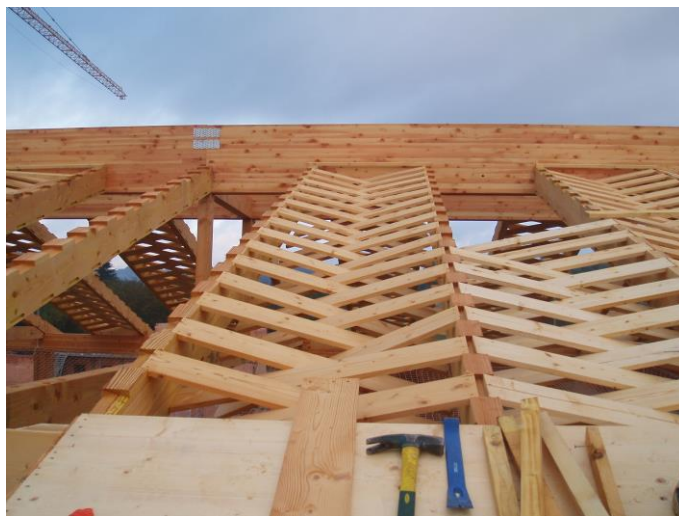
Fig. 13 Pose des étrésillons croisés
