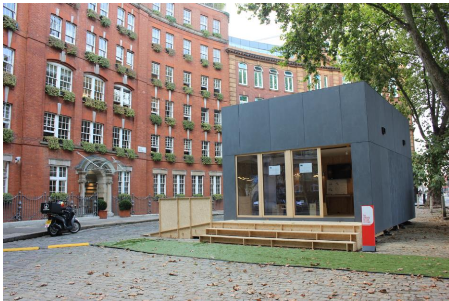
Fig. 20 Vue de la construction terminée
