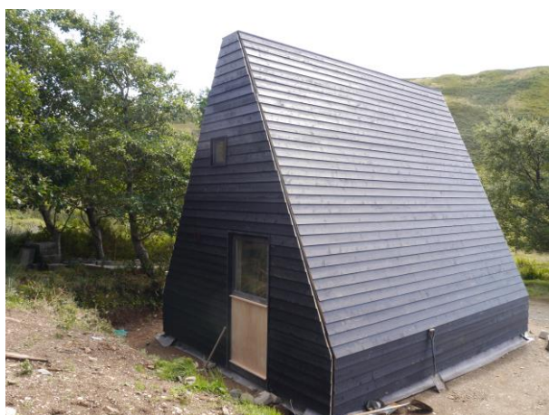
Fig. 28 Bardage à clins horizontaux de la A-Barn
