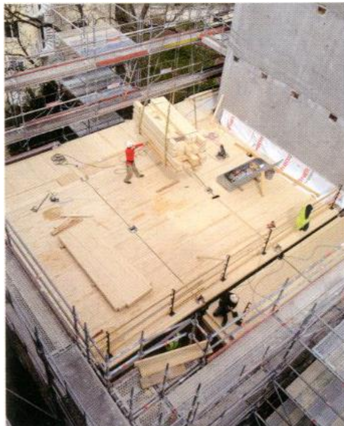
Fig.8 Panneaux de plancher en BLC
