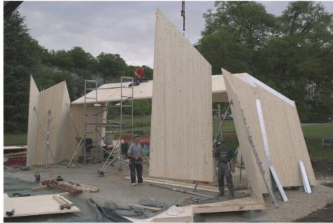
Fig. 18 Montage de la structure plissée
