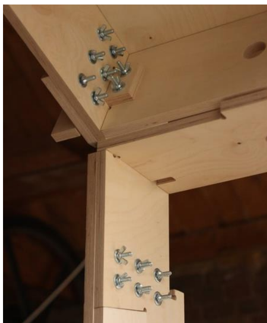
Fig. 8 Assemblages d'angle boulonnés
