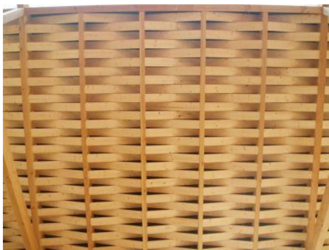
Fig. 14 Sous-face « tressée » acoustique
