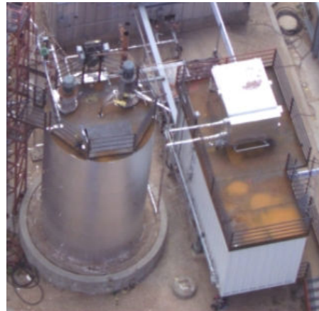
(b) Photographie de l'installation
