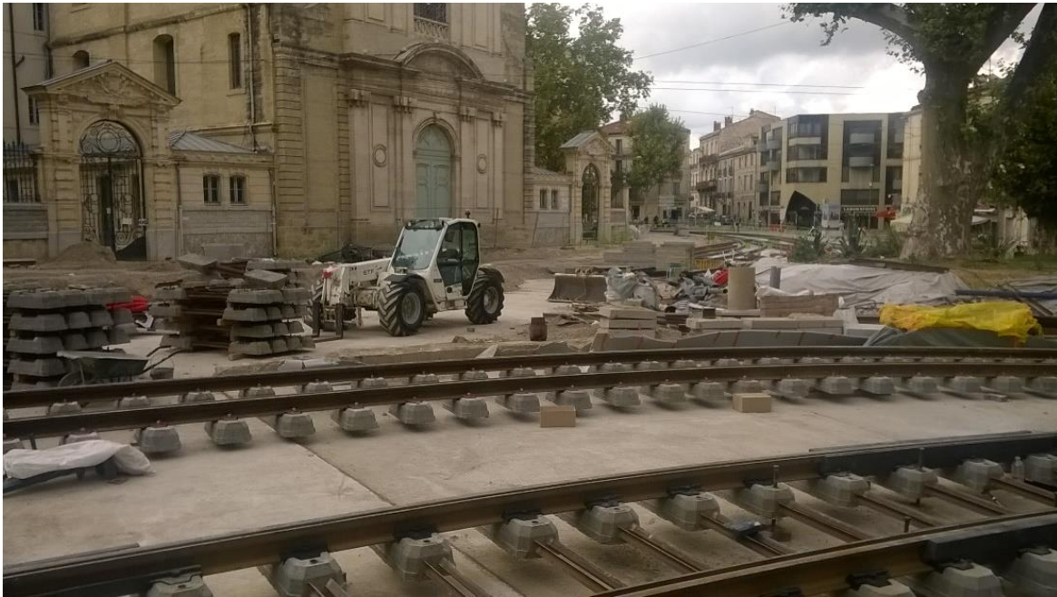
Image n°26 : Travaux place Albert 1 er , Montpellier
