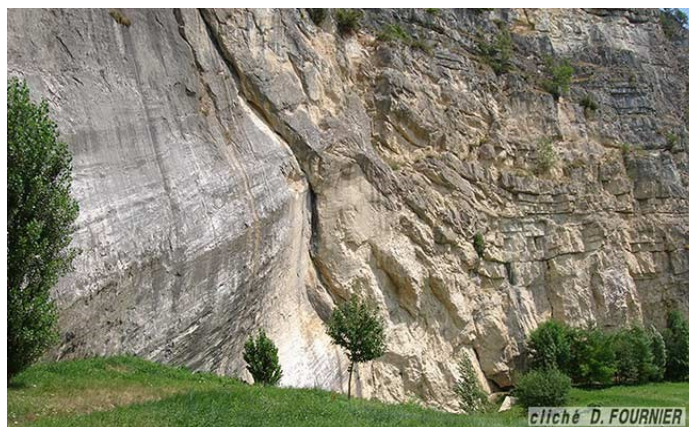
Figure III-36 : Photo du miroir de faille de La Balme de Sillingy, localisation sur la Figure III-37.
