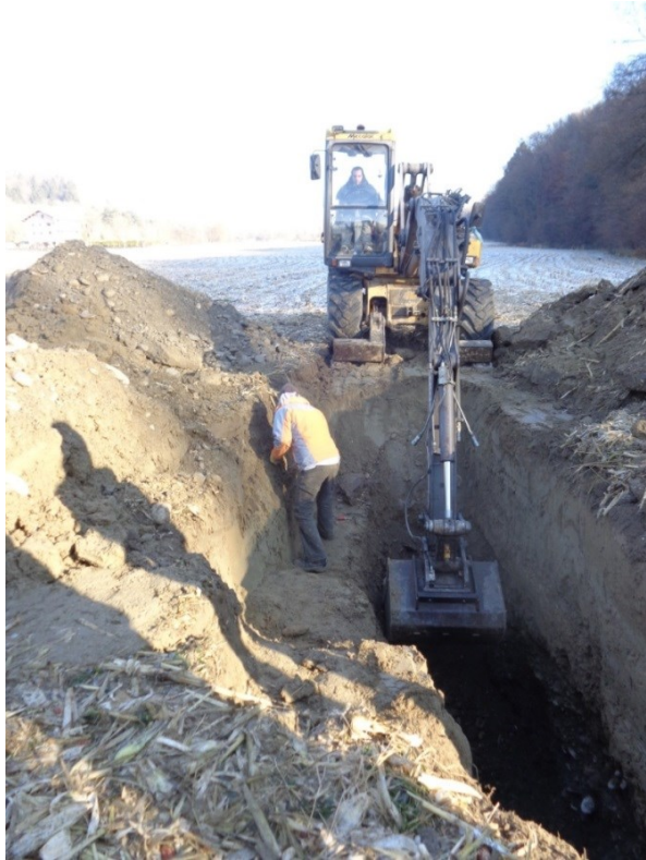
Figure III-32 : Photo du sondage réalisée à Sallenôves en décembre 2013, localisation sur la Figure III-24.
