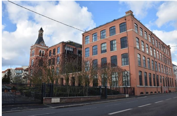
Photographie 30 : Des lofts au contact du jardin des plantes, rue d'Elbeuf, Rouen. Crédit photographique : M. Mercado, 19-02-2016
