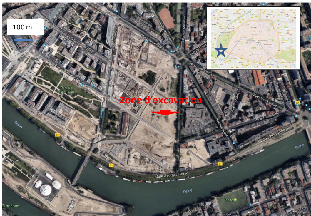
Figure 24:Photo aérienne du chantier d'excavation des terres de l'étude (Razel-Bec).
