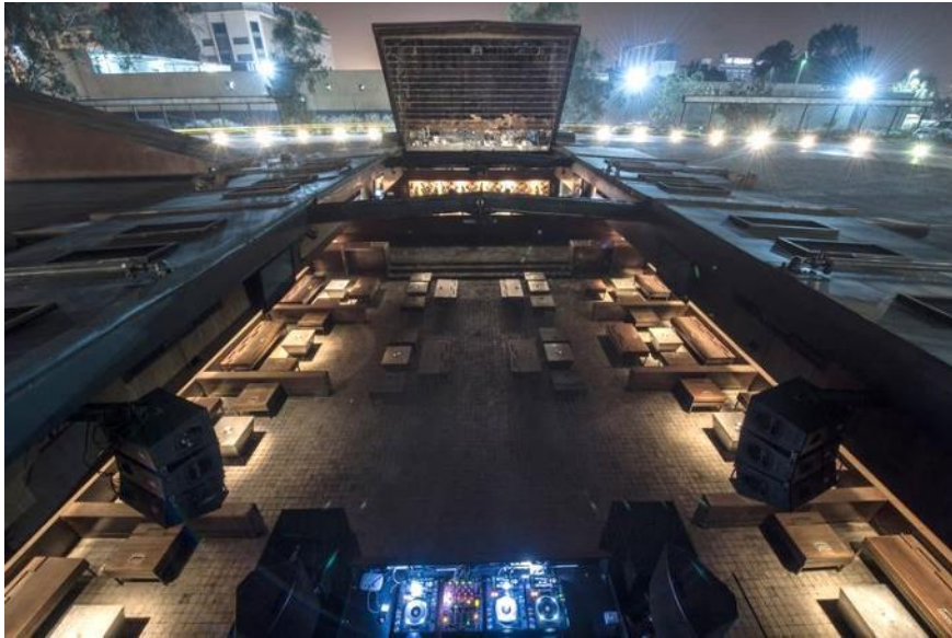
Figure 23 : le B018 avec son toit ouvert.
