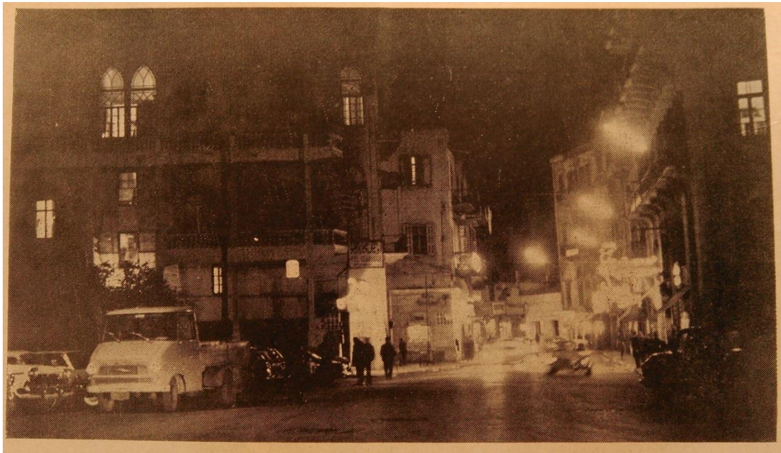
Figure 11 : l'entrée de la rue de Phénicie Source : Revue du Liban, décembre 1964
