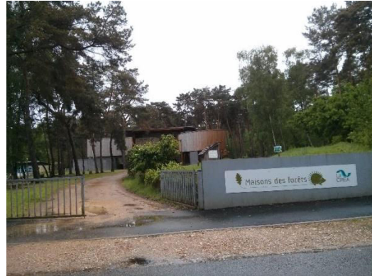
Photographie 23 : La maison des forêts située dans la forêt du Rouvray, Chemin des Cateliers, Saint-Étienne-du-Rouvray Crédit Photographique : R. Lepillé, 6 mai 2014.
