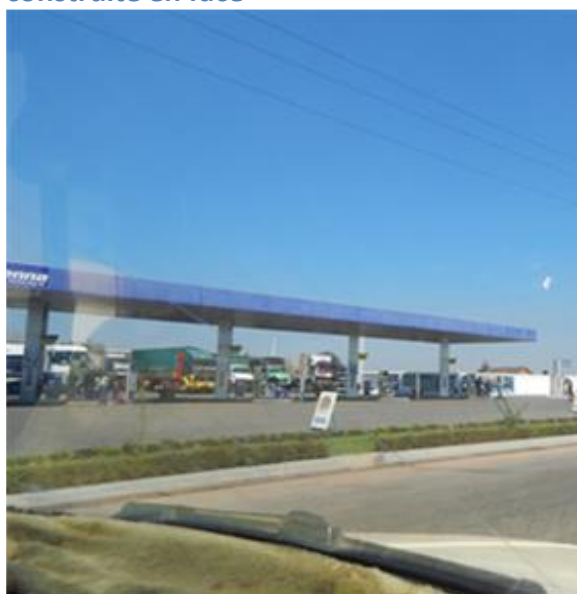
Photos 9 : Station-service Jovenna construite en face
