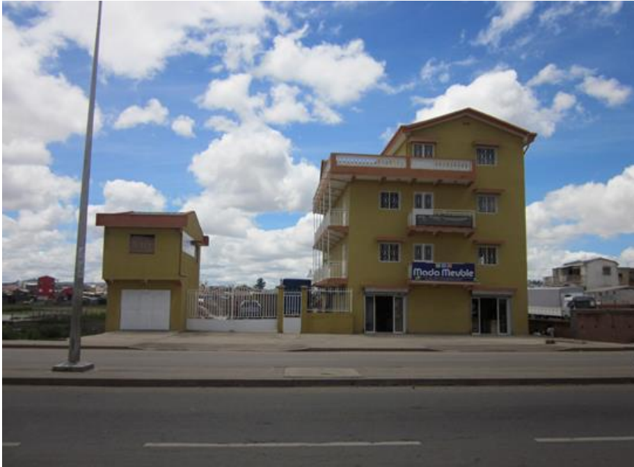
Photos 15 : Des nouvelles constructions érigées autour du boulevard de l'Europe (tronçon nord)
