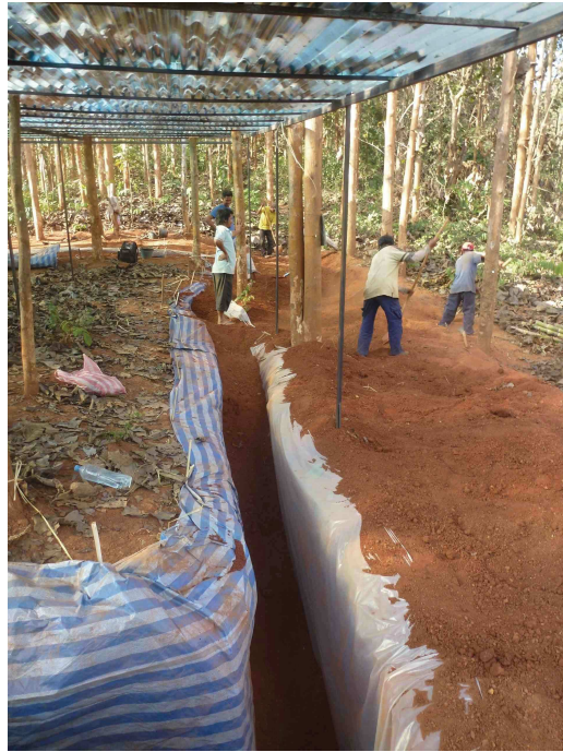
Photo 14: Tranchées en cours de réalisation (2.5 m de profondeur): mise en place des bâches d'étanchéité et rebouchages après collecte de racines
