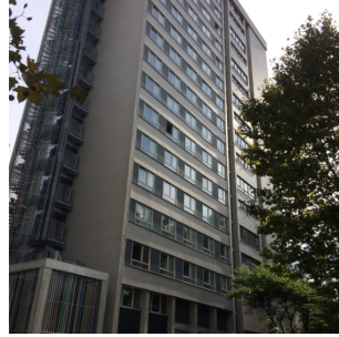
FIGURE 6.1 – Structure A : bâtiment résidentiel en service, doté de 15 étages. Les signaux proviennent du sol du treizième étage.
