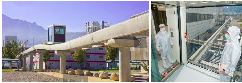
FIGURE 6.9 – Structure L : funiculaire utilisé comme salle blanche mobile. Les signaux vibratoires proviennent de l'une des poutres transversales en béton qui relient les rails.
