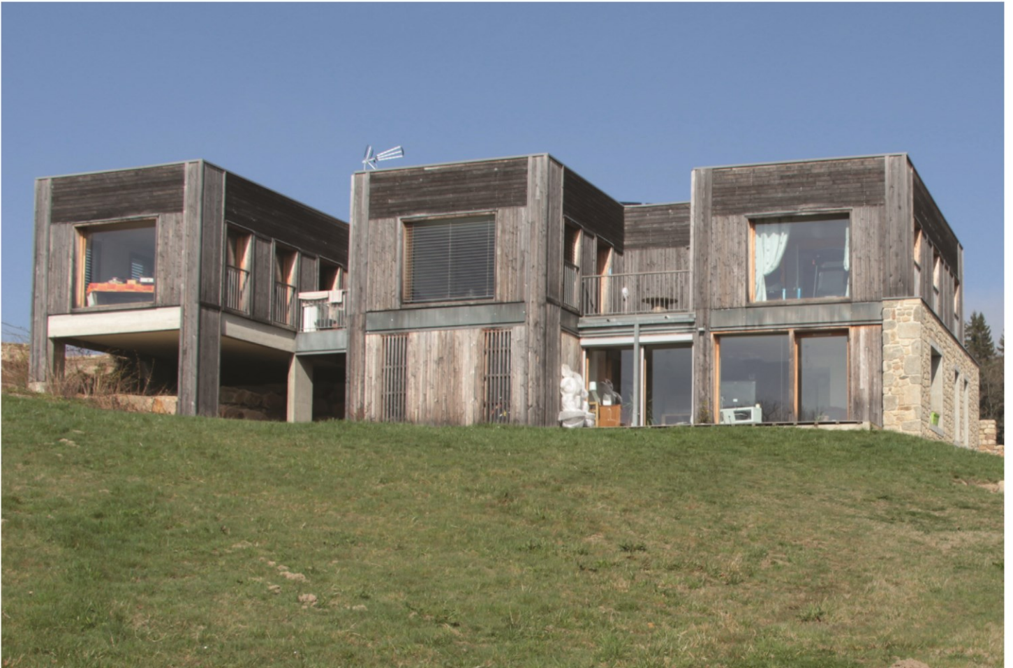
Photographie 8. Puy-Bayou : logements sociaux ouverts en façade sud par de larges baies vitrées et profitant de terrasses à l'étage et en rez-de-jardin
