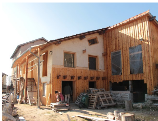
Photographie 39. Fabrication de portes et de fenêtres à partir du réemploi d'éléments de double vitrage à la Ferme du pot commun
