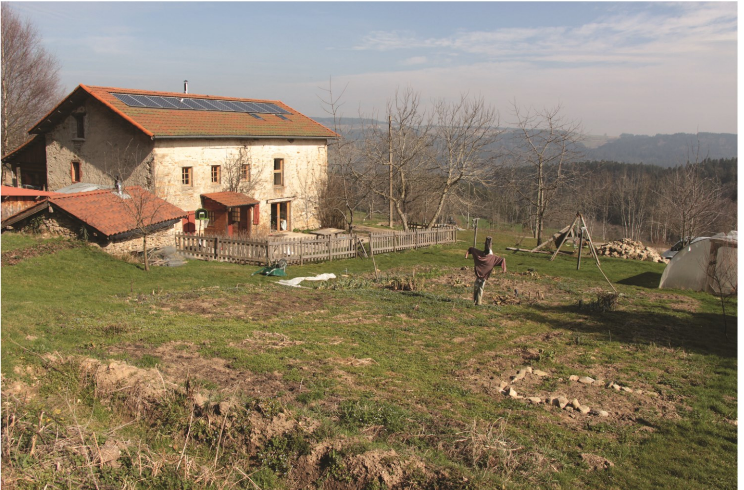
Photographie 19. P'tite ferme : façade sud de la bâtisse réhabilitée : panneaux photovoltaïques en toiture, terrasse et jardin potager en pied du bâti
