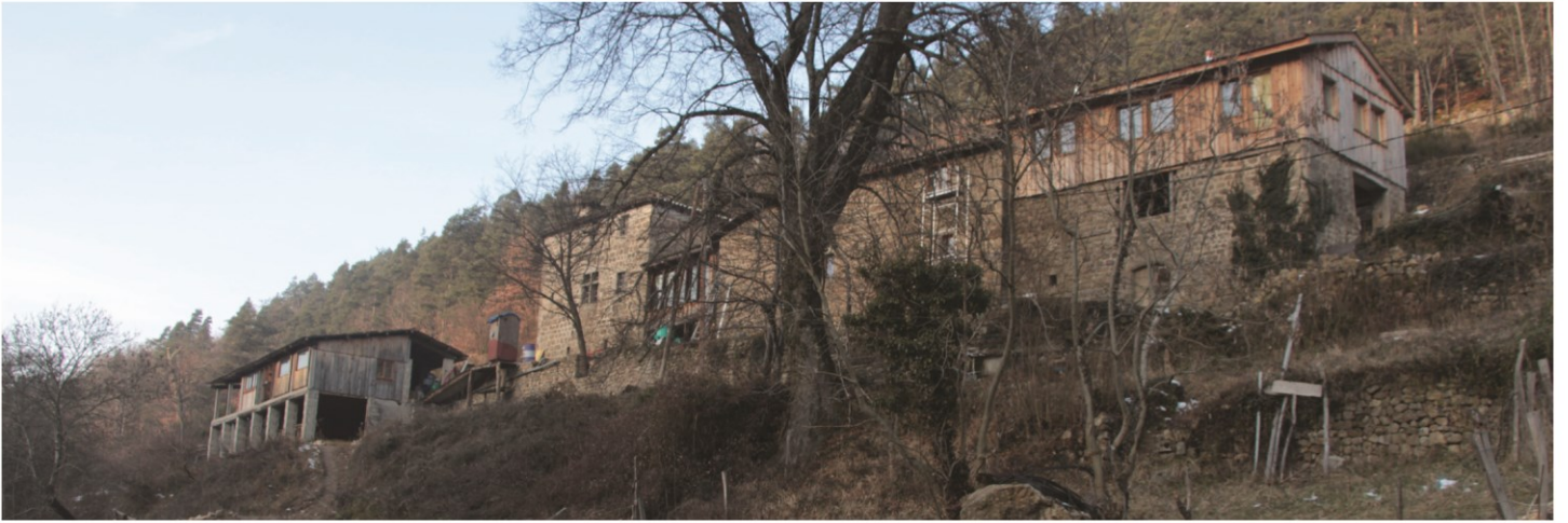
Photographie 29. Le Sauze : implantation du hameau dans un terrain en pente et aménagé par des terrasses
