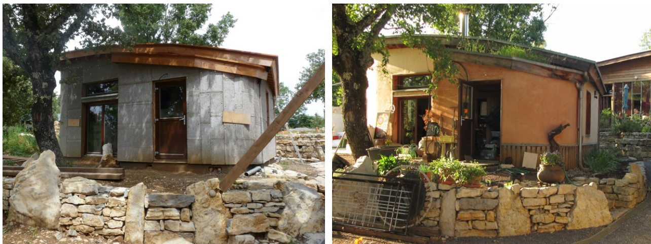
Photographie 42. Une des deux maisons indépendantes construites avec des murs arrondis au Hameau des buis, pendant et après la construction (photographie de gauche © Hameau des buis)
