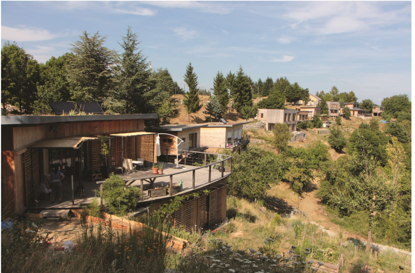
Photographie 4. Cintenat : implantation des maisons en partie haute des parcelles le long de la voie d'accès
