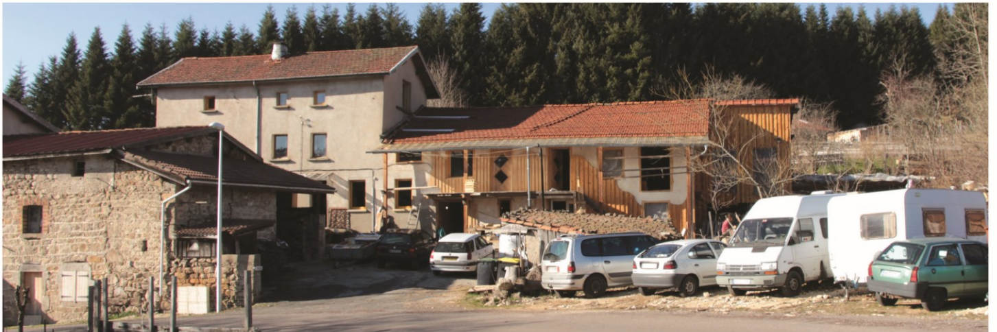
Photographie 26. Ferme du pot commun : façade sud de la maison réhabilitée et de l'extension bâtie
