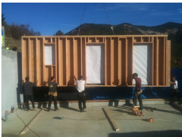
Photographie 38. Construction d'Habiterre en panneaux d'ossature bois (© Habiterre)
