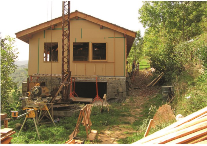
Photographie 30. Le Sauze : construction de l'extension en ossature bois en lieu et place de la grange
