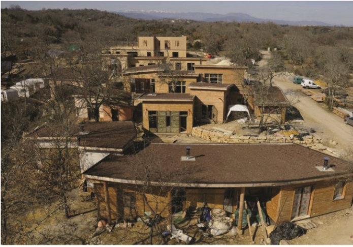
Photographie 17. Hameau des buis : construction progressive des différents logements mitoyens, structures bois et toitures végétalisées (© Xavier Pagès)
