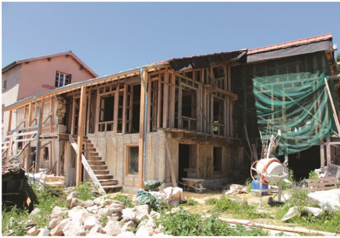
Photographie 25. Ferme du pot commun : construction de l'extension bâtie en structure bois
