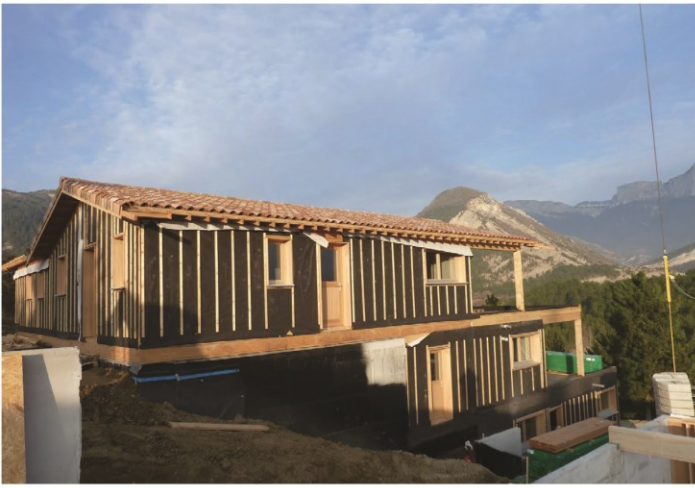
Photographie 14. Habiterre : construction d'un bâtiment sur soubassement béton surmontés de panneaux de bois préfabriqués (© Habiterre)
