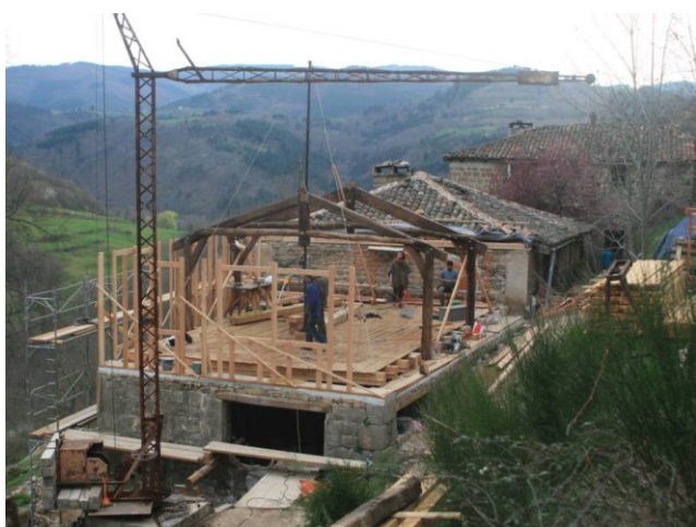
Photographie 40. La charpente et les menuiseries réemployées dans le hameau du Sauze (photographie de gauche © LAO construction)
