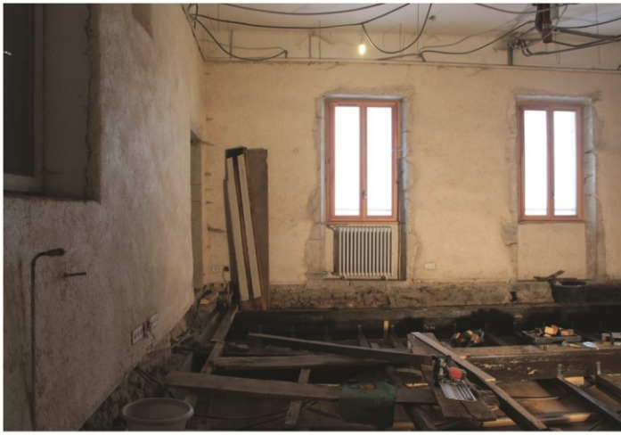
Photographie 11. Château partagé : réhabilitation en cours du dernier logement
