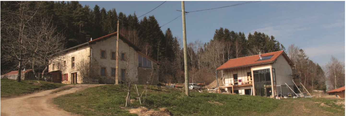
Photographie 20. P'tite ferme : réhabilitation de la bâtisse ancienne par le percement de nouvelles fenêtres et construction d'une maison neuve en ossature bois comportant une serre bioclimatique
