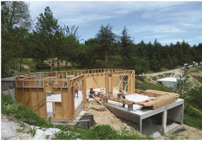
Photographie 6. Cintenat : construction d'une maison avec un soubassement en béton et une ossature en bois (© Dominique Midol)
