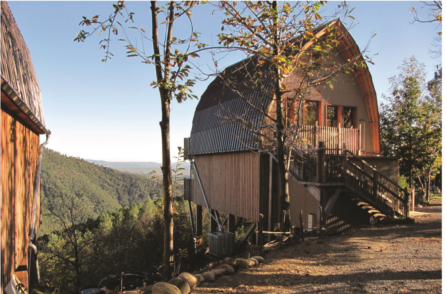
Photographie 3. Bogues du Blat : maisons sur pilotis implantées dans la pente et orientées vers le grand paysage
