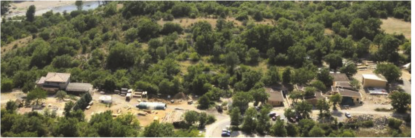
Photographie 16. Hameau des buis : logements en construction et mas existant implantés au milieu de la garrigue (© Xavier Pagès)
