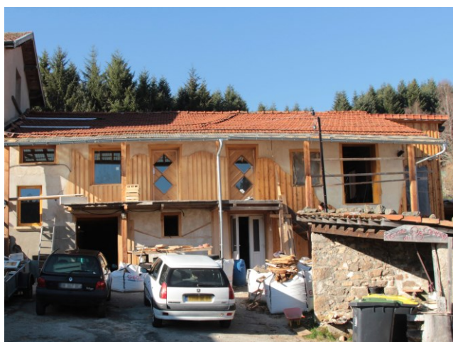
Photographie 39. Fabrication de portes et de fenêtres à partir du réemploi d'éléments de double vitrage à la Ferme du pot commun
