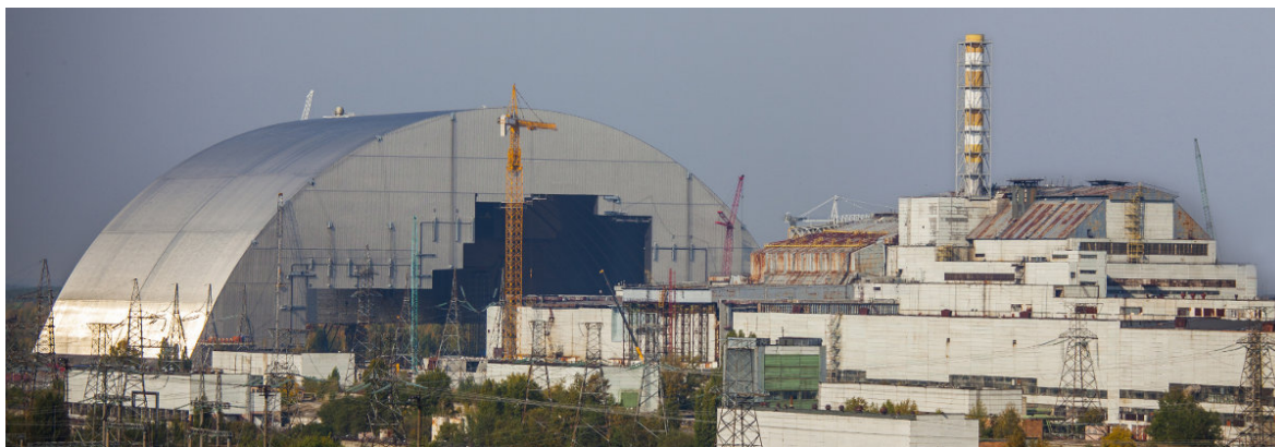
FIGURE 1.9 – Nouveau sarcophage ( New Safe Confinement , à gauche), peu avant son installation sur le réacteur accidenté (à droite) 60
