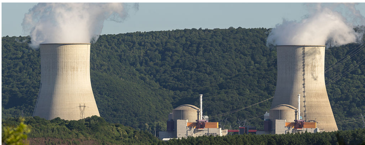
FIGURE 1.5 – Centrale nucléaire de Chooz (Ardennes). Les deux réacteurs sont logés dans les deux bâtiments cylindriques au premier plan. Les cheminées, plus à l'arrière, sont destinées au refroidissement des réacteurs (certaines centrales, refroidies grâce à l'eau d'une mer ou d'un cours d'eau, ne sont pas équipées de telles cheminées) 36
