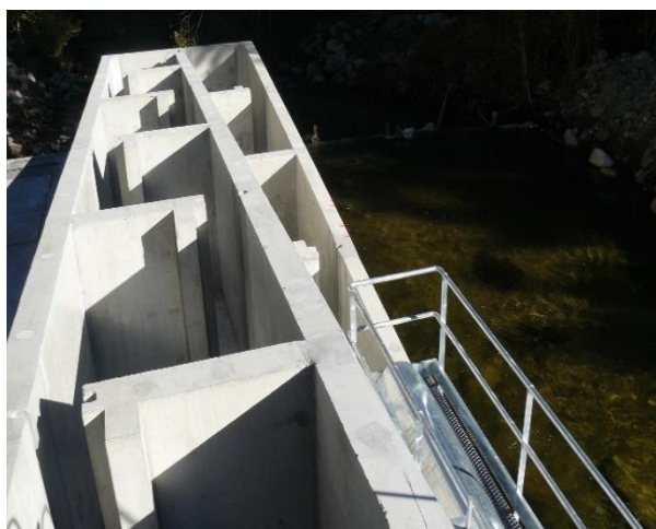
Photos n°20 et 21 : Photos après travaux avec la nouvelle passe à bassins successifs de l'usine de la Cassagne avec la prise d'eau de la Salitte (Perrin J-A, 2015)
