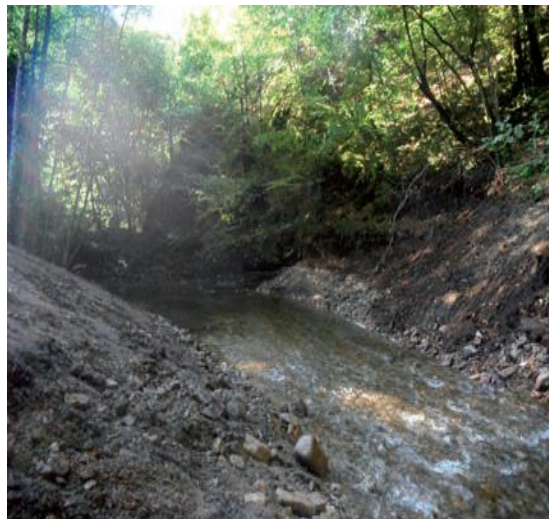
Photo n°16 : Vue aval du site après-travaux en 2013 (SMPVD)
