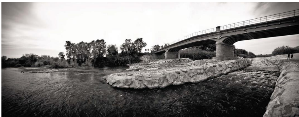
Photo n°19 : Vue d'ensemble du seuil du Canet après travaux (source : Photo MRM)
