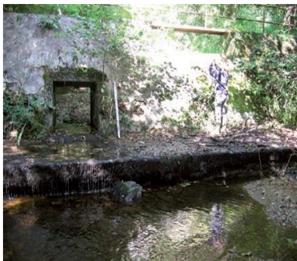
Photo n°15 : Vue aval du site avant travaux en 2011 (SMPVD)
