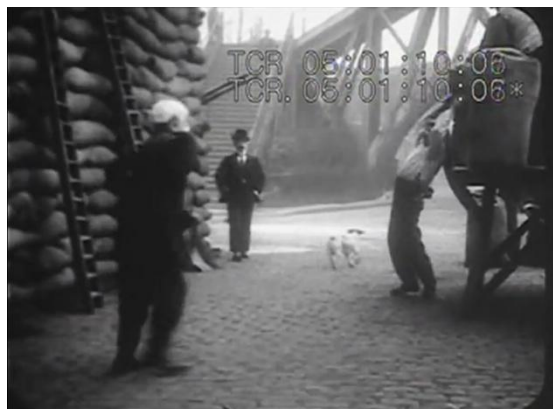
1. O velho estivador entra no quadro em primeiro plano, enquanto o contramestre sai de trás da pilha de sacos.
