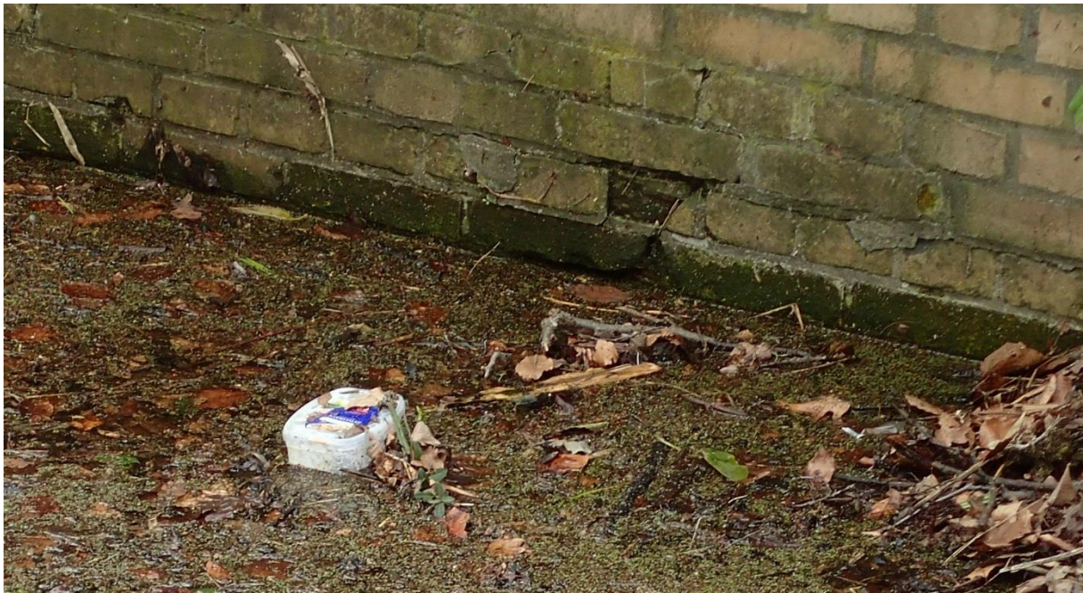
Fig. 26. Bidon en plastique dans un canal de drainage (Berlin, Allemagne, 2016).
