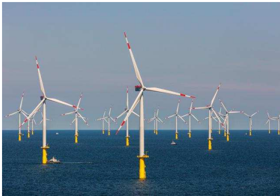
a) Eoliennes off-shore posées
