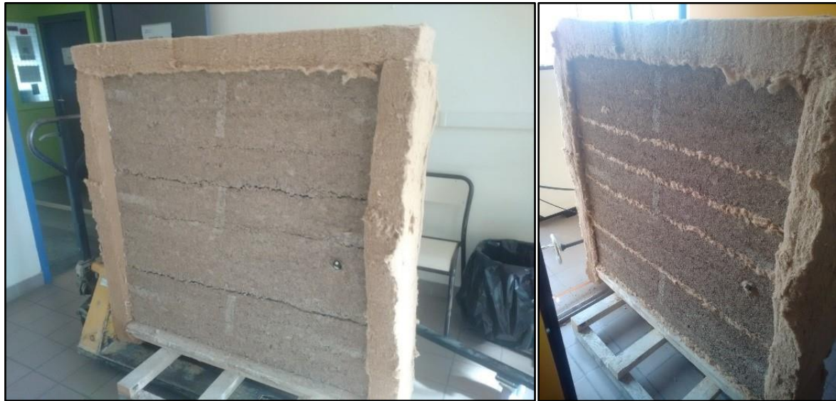
Figure 4-15. Enduit isolant de composition RSD5 appliqué sur la paroi en tuffeau avant colmatage des fissures à l'aide de laine bois à gauche et après à droite
