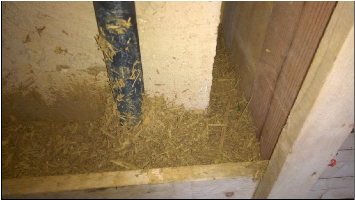
Figure 2-17. Mélange terre-colza banché, presbytère de Chédigny (37)
