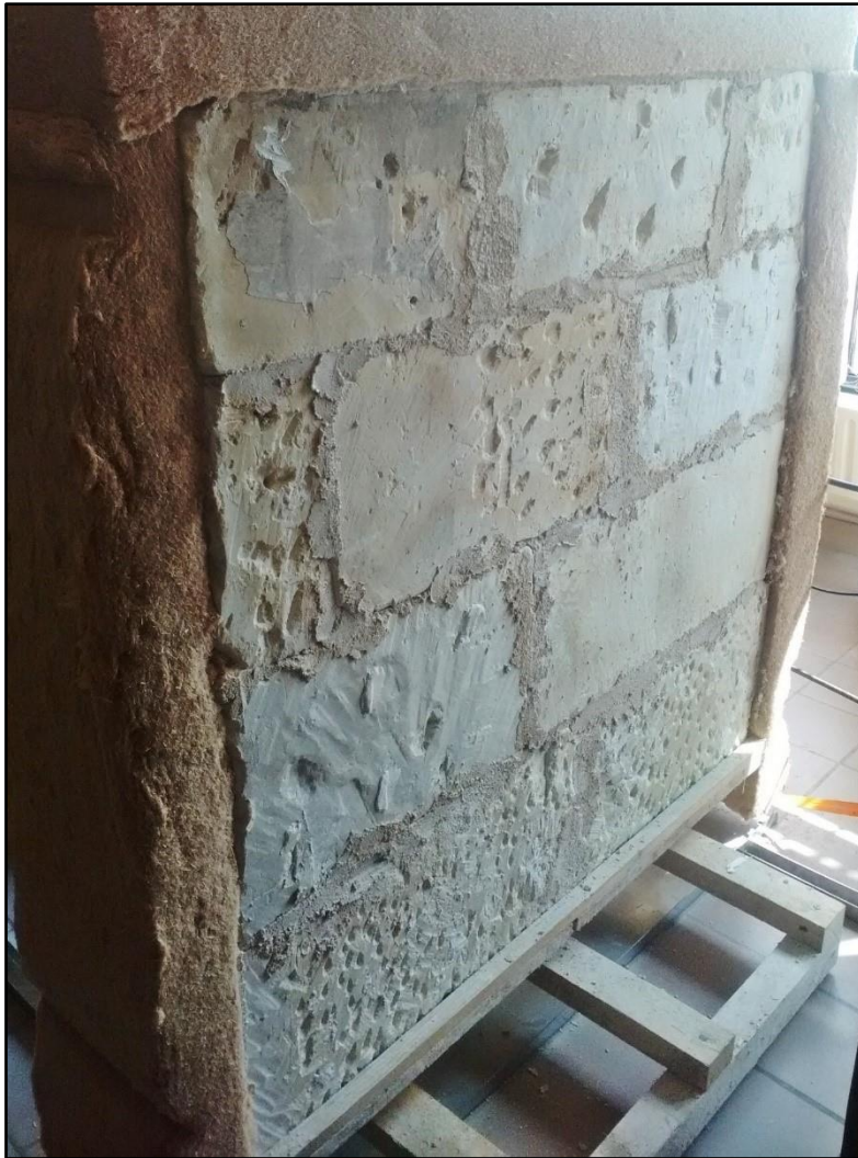
Figure 4-14. Paroi de pierres de tuffeau maçonnées à la chaux
