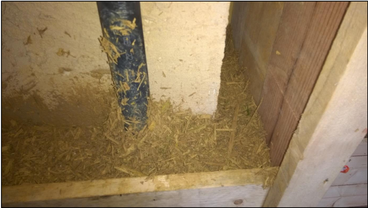
Figure 2-17. Mélange terre-colza banché, presbytère de Chédigny (37)
