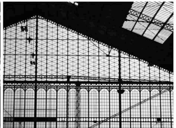
Verrière de la gare d'Austerlitz (Paris)
