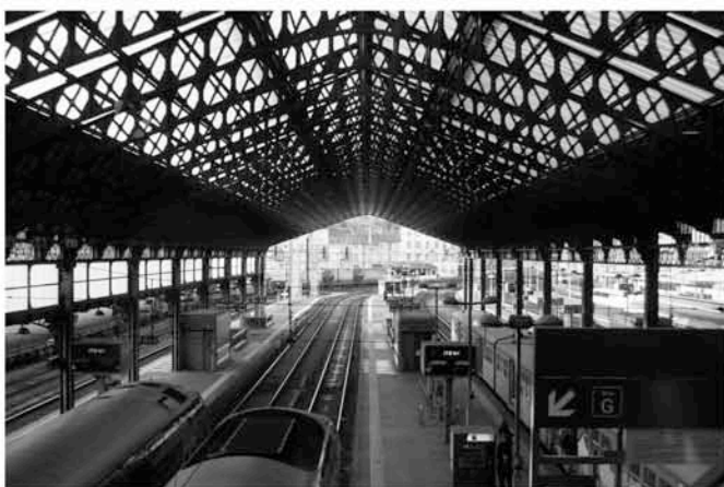
Halle Polonceau (Gare de Lyon-Perrache)
