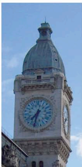
Campanile de la gare de Lyon (Paris)
