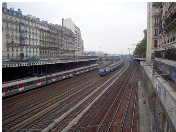
b. Voies ferrées au niveau des Batignolles en amont de la gare Saint-Lazare : 30 mètres de coupure avec encaissement (A. Delage, 24.11.2011)
