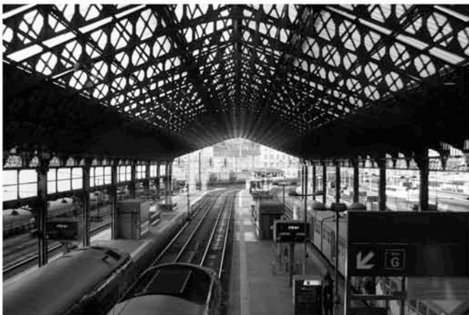
Halle Polonceau (Gare de Lyon-Perrache)
