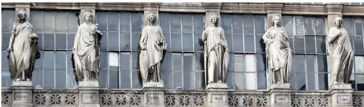
"Une centralité triomphante sculptée dans la pierre, au fronton des gares" (Sauget, 2009, p. 202) Fronton de la gare du Nord, avec le nom des villes traversées par le réseau (Paris)
