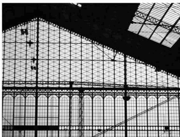
Verrière de la gare d'Austerlitz (Paris)
