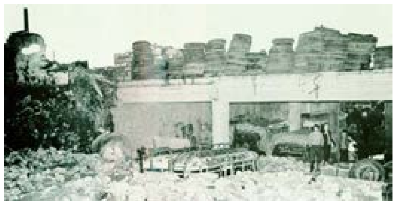
Le garage de Bab et-Tabbaneh recouvert de gravats charriés par la crue du 17 décembre 1955. Source : collection de l'auteur.
