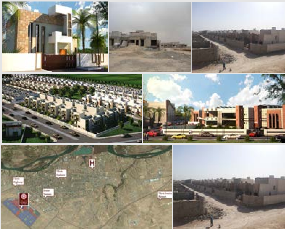
Figures n° VII.8. – Vues du projet Tikrit Jewel (Irak) dont les montages financiers et juridiques ont été réalisés par SACS Inc.
