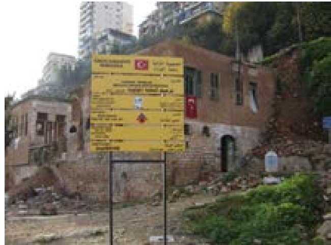
Panneau du chantier de restauration de la dervicherie (durée des travaux 540 jours- hors CHUD)
