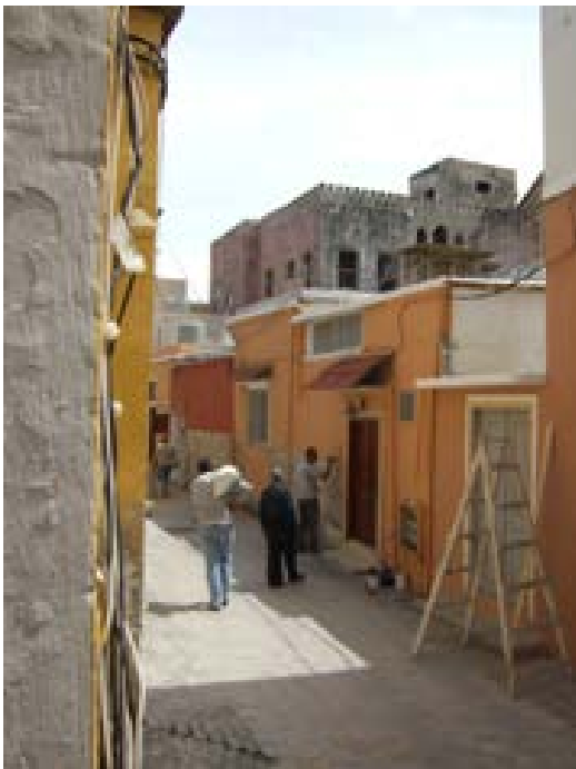
Rénovations des façades en vieille ville.
