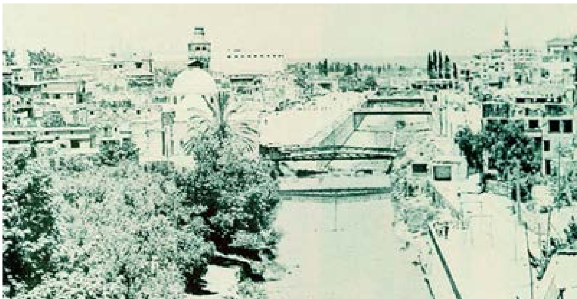
Photo n° VII.7. – Travaux de rectification et d'endiguement du lit du fleuve Abou Ali en 1960
