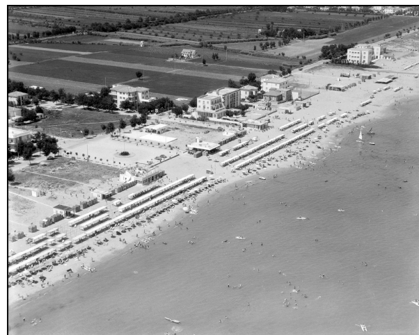
Misano Adriatico, 1959-1965 - La plage est occupée par des établissements de plage et on note les premiers édifices.
