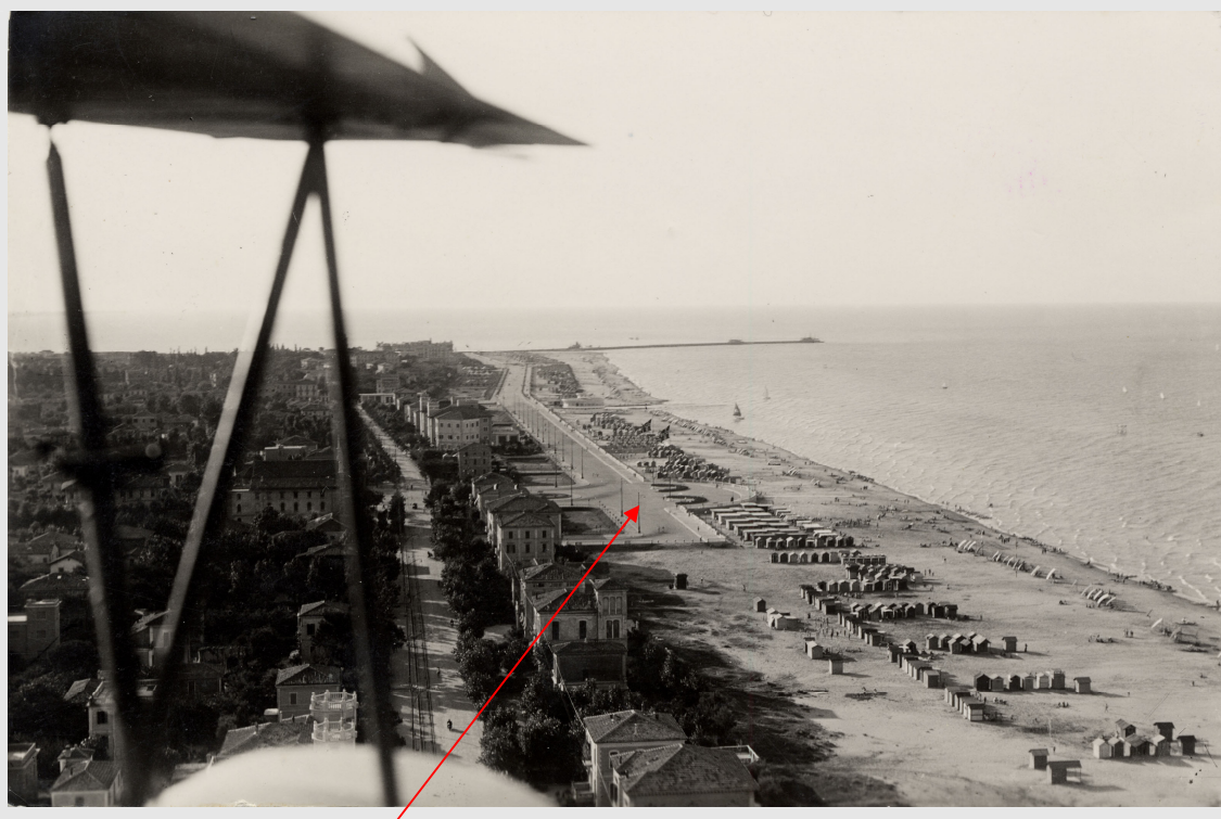
Photographie aérienne, 1935 env. On note l'existence d'un remblai entre le port, dont on voit la jetée au fond et la Piazza Tripoli. On note aussi la fin du remblai à hauteur du Viale Tripoli. Il sera prolongé en 1942.
