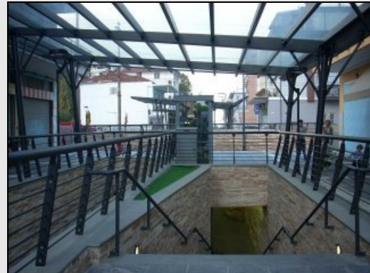
TRC - Passage piétonnier souterrain, quartier Lagomaggio, Rimini
