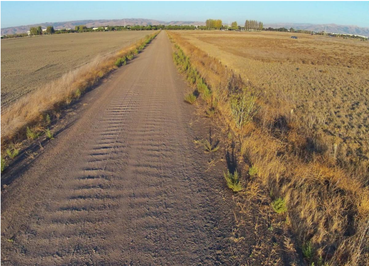
FIGURE 2.1 – Exemple de route en tôle ondulée. On observe un motif régulier de rides transverses et régulièrement espacées qui s'est développé sur toute la longueur de la piste. Photographie tirée de [Percier, 2013].
