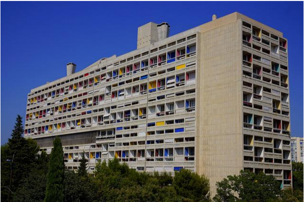
Figure 8 : Unité d'habitation, Marseille, par Howard Stanbury CC-BY-NC-SA-2.0
