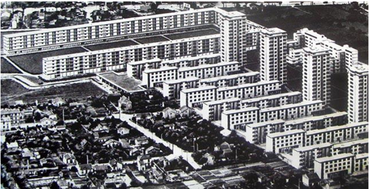
Figure 7 : un exemple de grands ensembles : la cité de la muette à Drancy
