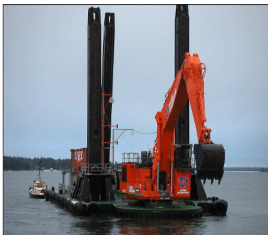
Figure B-3 : Photographie d'une dragage mécanique qui fait partie intégrante de l'infrastructure (Marrec A., 2012)
