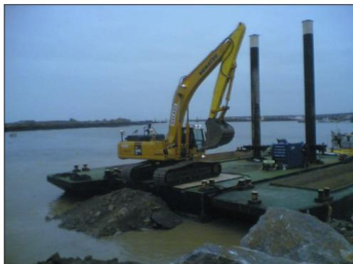
**Figure B-2 : photographie d'un dragage mécanique par une pelle hydraulique mobile équipée pour des travaux maritimes (Marrec A., 2012)**
