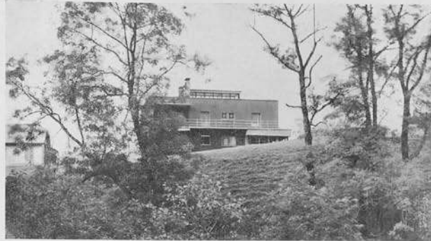
M. LE MÊME, ARCHITECTE. — VILLA PERSONNELLE À MÉGÈVE, LA FAÇADE MIDI
