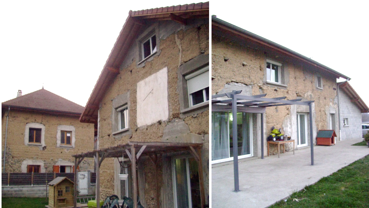
Figure 22. Photos de la maison de Sabine et Maxime, avril 2014. Les travaux intérieurs sont terminés et l'extérieur est pour le moment laissé en suspens.
