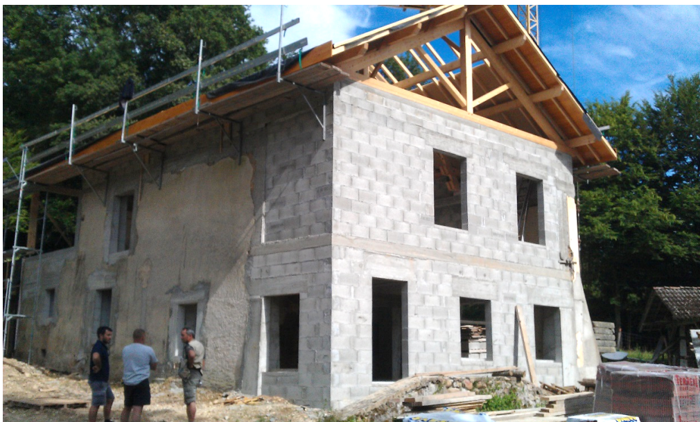
Figure 6. Maison de Clément et Marion en travaux lors de la visite de chantier en juin 2015.
