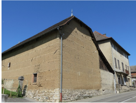
Figure 9. Bâtiments en pisé dans une rue du village de Dolomieu, Isère, juillet 2014.
