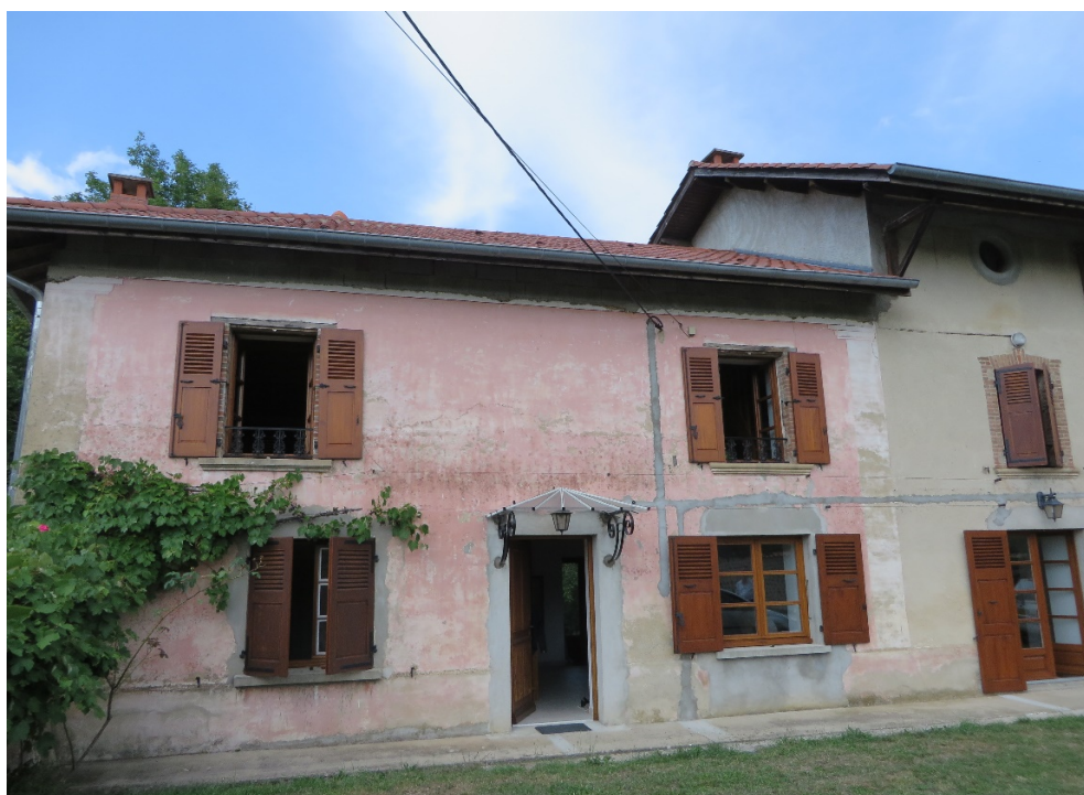
Figure 16. Maison en pisé enduite, sur laquelle on peut lire en façade différentes interventions (déplacement d'une porte, installation des réseaux électrique, rehausse sous toiture). Chatenay, juillet 2015.
