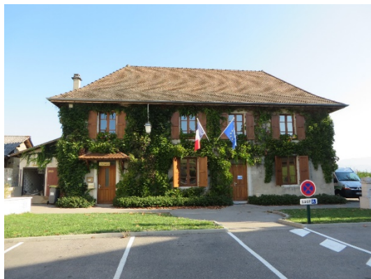
Figure 13. Mairie de Charancieu, aménagée dans une ancienne maison en pisé. Juin 2015.
