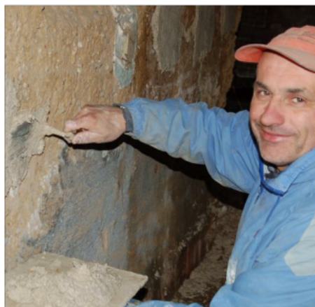
Le patron de Bernard Berthet, ouvrier en maçonnerie à Romagnieu, a souhaité qu'il suive cette formation, afin qu'il élargisse son savoir-faire, compte tenu de ses chantiers en façades. Bernard applique sur le mur de la cure, l'enduit.
