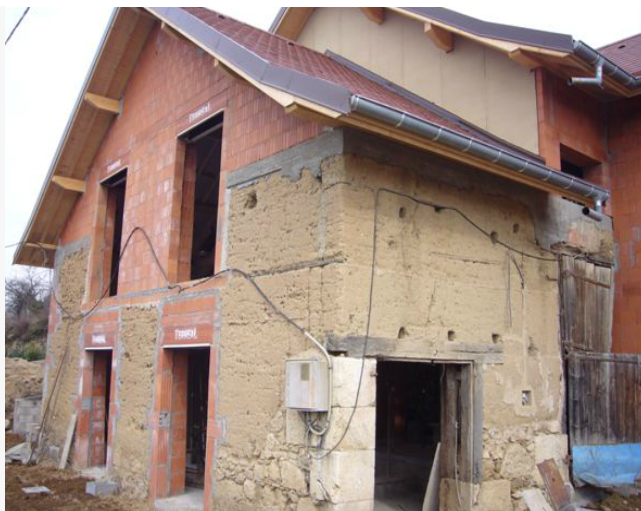
Figure 32. Extraits du site internet de l'entreprise de Bruno qui présente l'entreprise et ses prestations sur la rénovation de maisons en pisé. ©Bruno Pinjon Bâtiment
