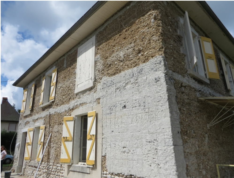
Figure 44. Chantier de Benoît et Amélie, août 2015. Une fois que le pisé a été jugé en suffisamment bon état par le maçon, Benoît s'est attelé à dénuder l'ensemble de la maison de son enduit, à l'extérieur comme à l'intérieur. Cette phase de travaux a duré plus de 2 mois.
