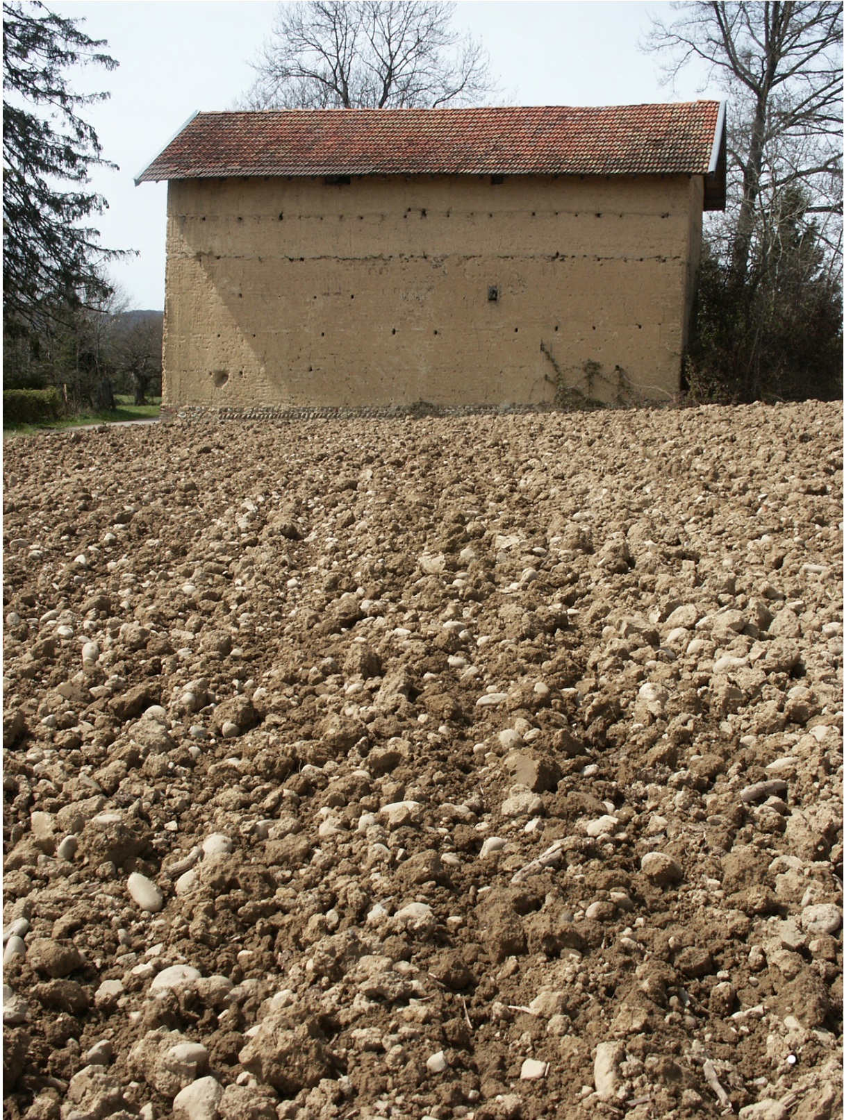
Figure 1. Mur en pisé dans un champ de terre. Champier. © Patrice Doat. On peut observer sur cette photo, où la terre a été labourée, comment la terre à pisé est constituée de plusieurs grains de différentes tailles (cailloux, graviers, sables, limons et argiles).
