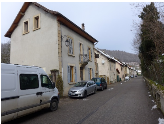
Figure 12. Quartier ouvrier construit en pisé à Saint Bueil. Janvier 2016. © Mathilde Chamodot
