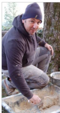
Paulo Vieira est artisan à la Tour-du-Pin. Cette formation est pour lui une manière d'enrichir ses connaissances. Il s'active sur notre cliché à préparer de l'enduit avec 1 volume de terre, 2 volumes de sable et 2 volumes de paille.
