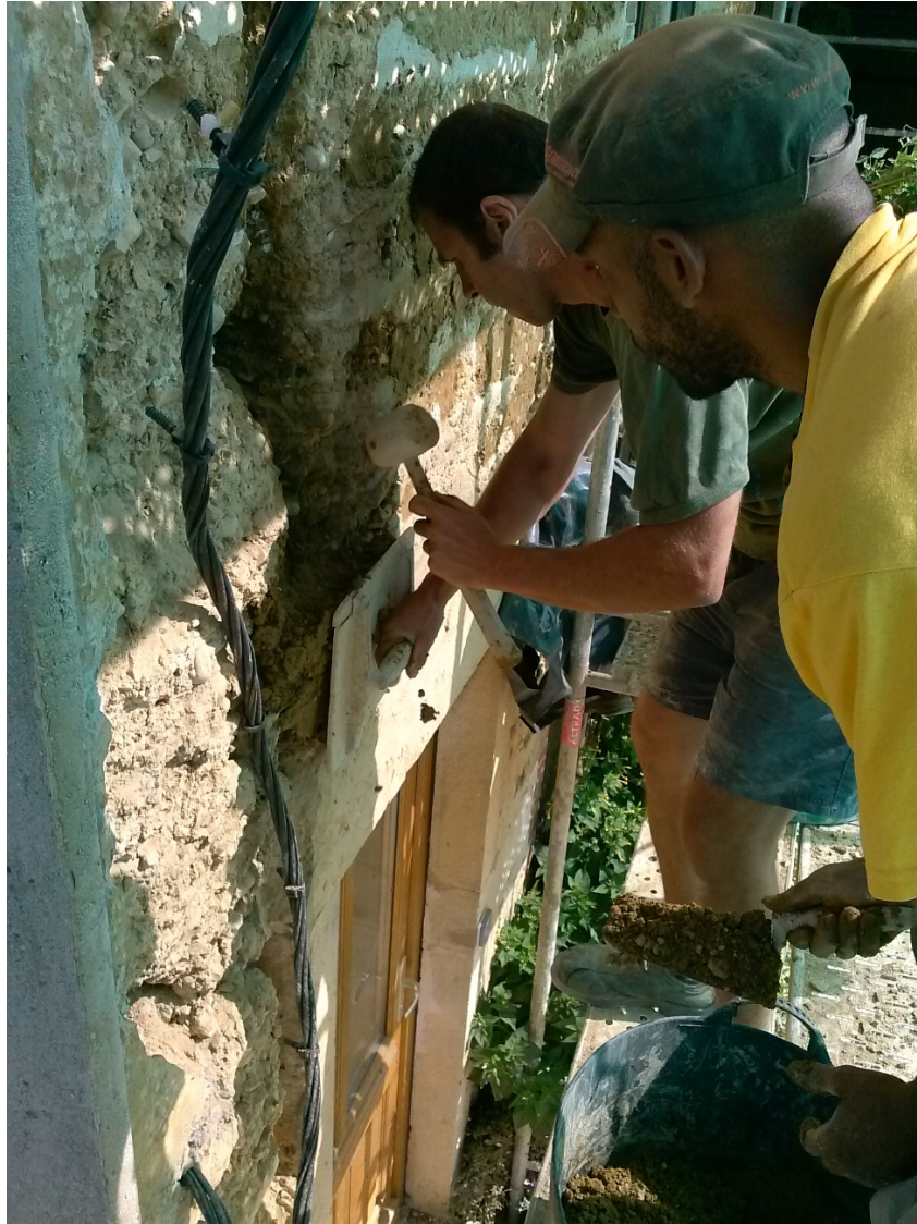
Figure 65. Apprentissage d'une technique de restauration du pisé avec rebouchage des trous et fissures avec de la terre crue. Chantier de Torchefelon. Entreprise Heliopsis. Juillet 2015. Photo ©Yohann Hoang Tho.
