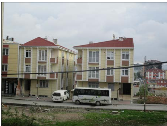
Immeubles neufs construits récemment par un même promoteur immobilier. Sur la façade principale, des tuyaux noirs et épais acheminent le gaz naturel jusque dans les logements.
