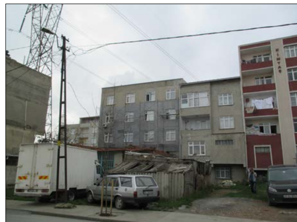
Travaux d'isolation en cours. Les seuls que nous ayons repérés dans ces quartiers.
