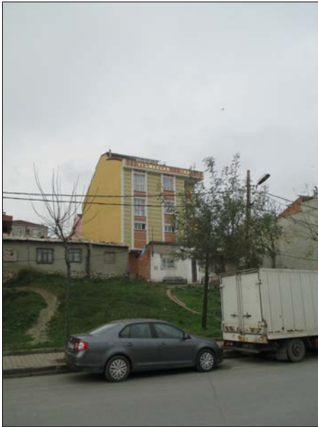
Un immeuble type apartkondu surplombe deux petites maisons de gecekondu . Deux formes architecturales reflètent de l'évolution du cadre bâti à Güvercintepe.
