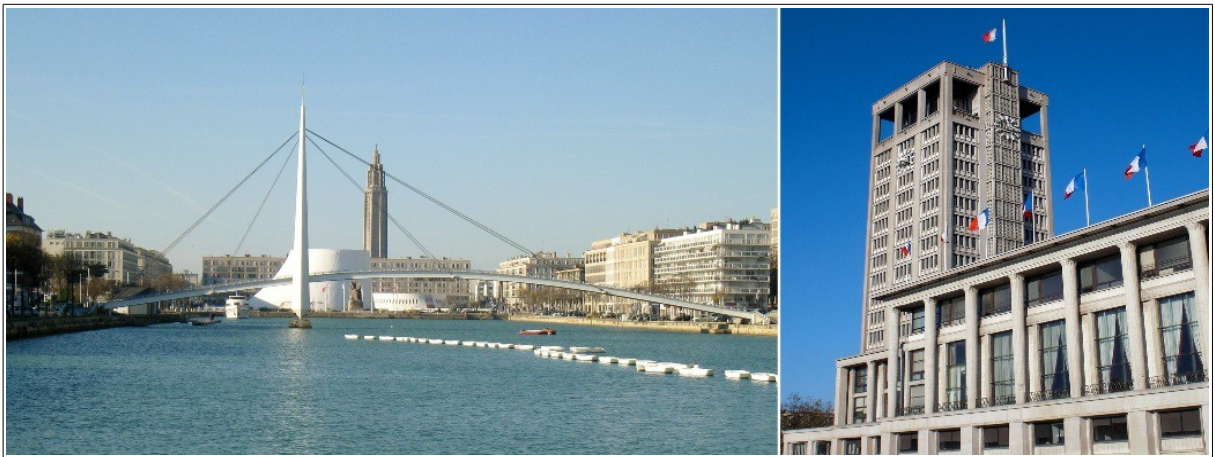
Figure 44 : Le centre ville du Havre reconstruit par Auguste Perret Crédits photos : Furlanetto G., 2011.
