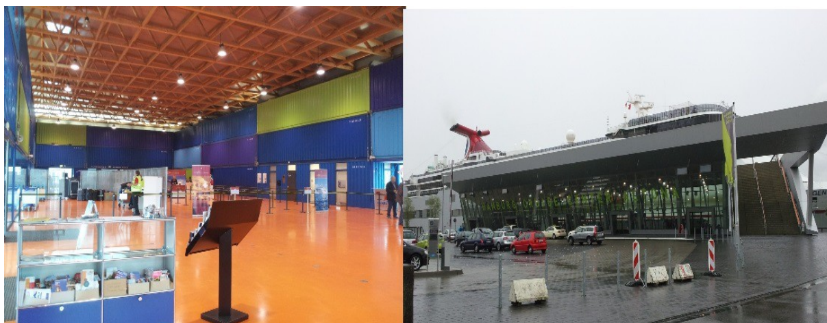
Figure 69 : Terminal d' HafenCity et Altona à Hambourg Crédits photos : Furlanetto G., 2013.
